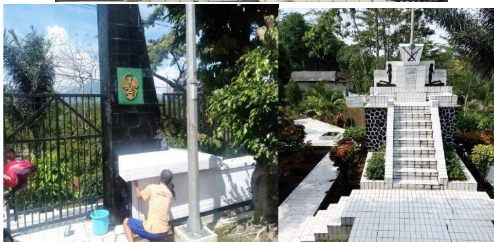
Perbaikan gerbang Makam Pahlawan Bambang Sugeng yang dilaksanakan pada 25 September 2023.
